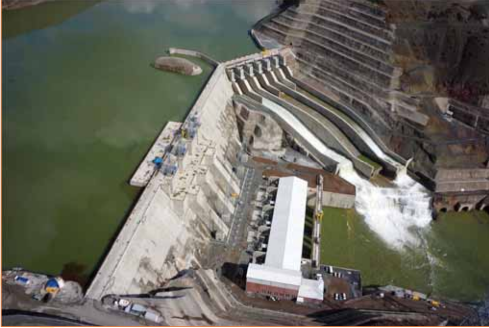
Resim 5. Baraj Gövdesi, Dolusavak ve Enerji Santrali
