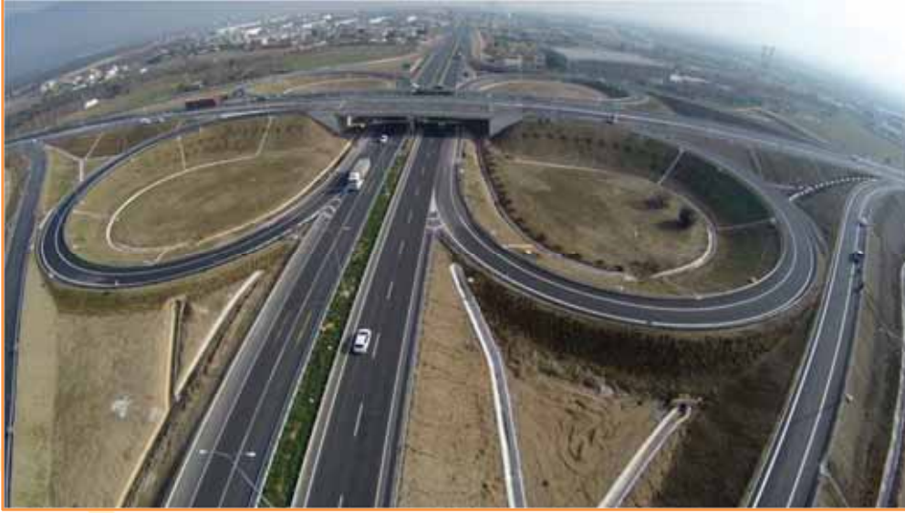
Resim 10. Faz-1 Otoyol Kısımı
