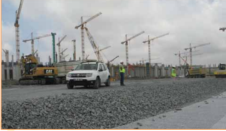
Resim 14. Terminal Binası Alanı
