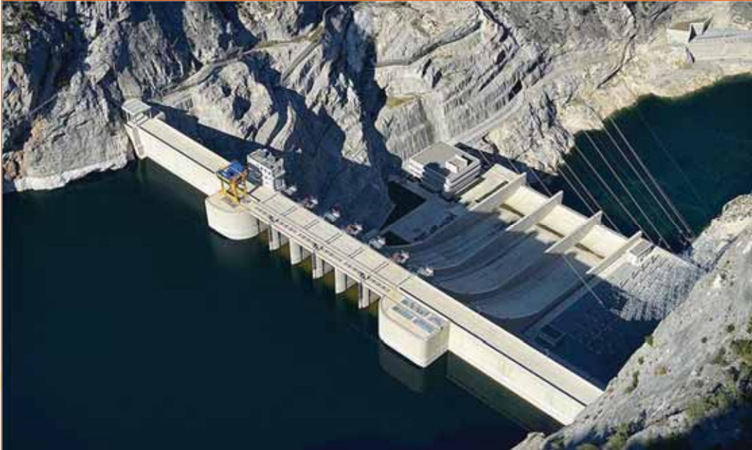
Resim 2. Baraj Kreti, Su Alma Yapısı ve Dolusavak
