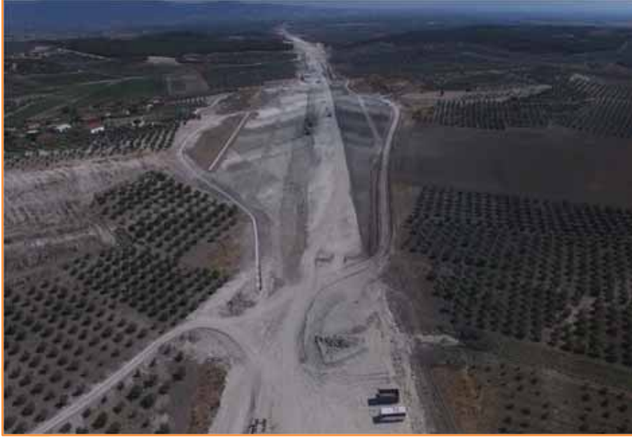
Resim 12. Faz 2 İnşaat İşleri
