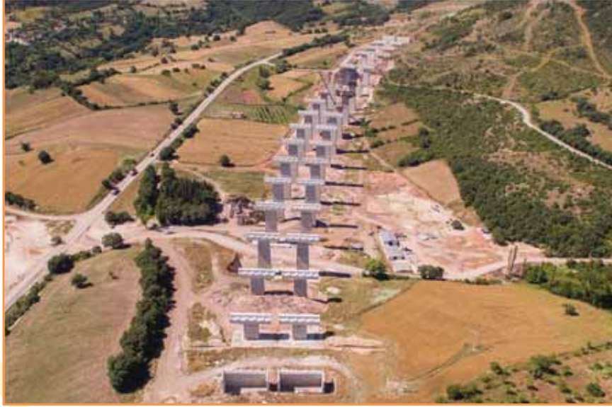
Resim 13. Faz 2 İnşaat İşleri
