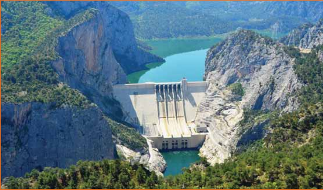
Resim 1. Baraj Gövdesi, Dolusavak ve Enerji Santrali
