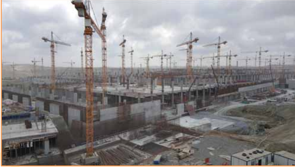
Resim 15. Terminal Binası Alanı
